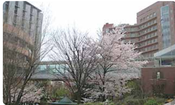
病院と研究所をつなぐ「夢の架け橋」
